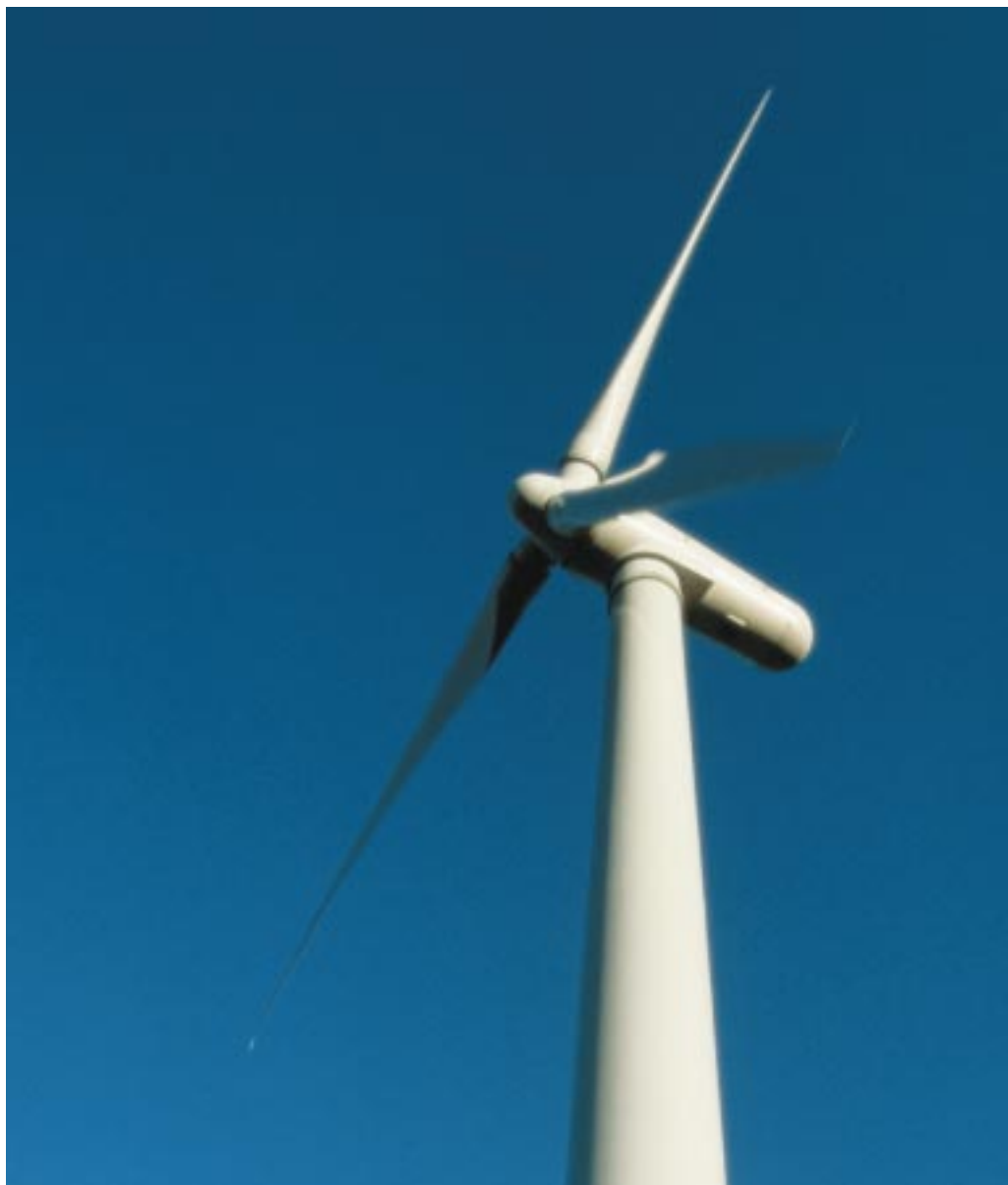
Vindkraftverket Elin täcker nästan 20 procent av energibehovet för Swedish Matches snusfabrik i Göteborg.
